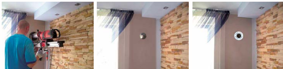
Rys 4. Wzór montowania układu wentylacji dolotowo-wyciągowej PRANA-150, PRANA-200.
